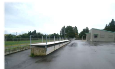
地下埋設管（外観）
