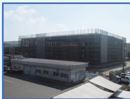
鹿児島工場併設の食肉加工工場(建設中)
