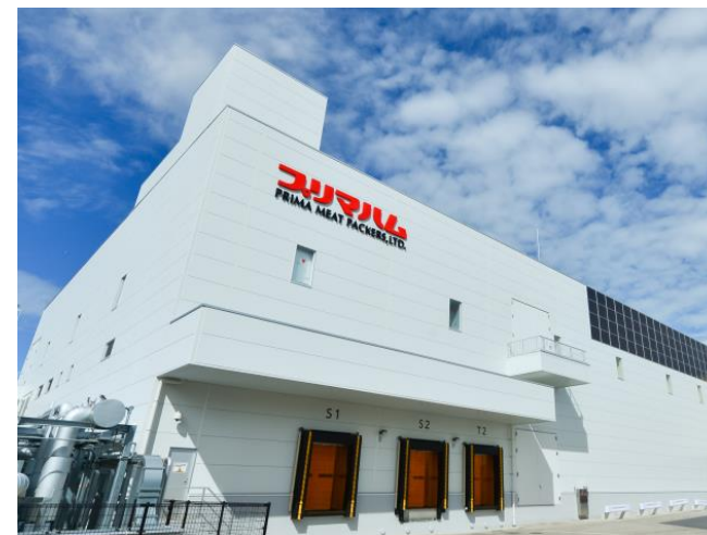
太陽光発電システム導入
