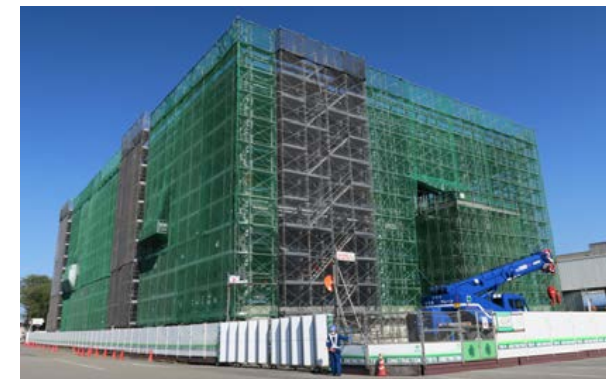
増設中の関東物流センター
