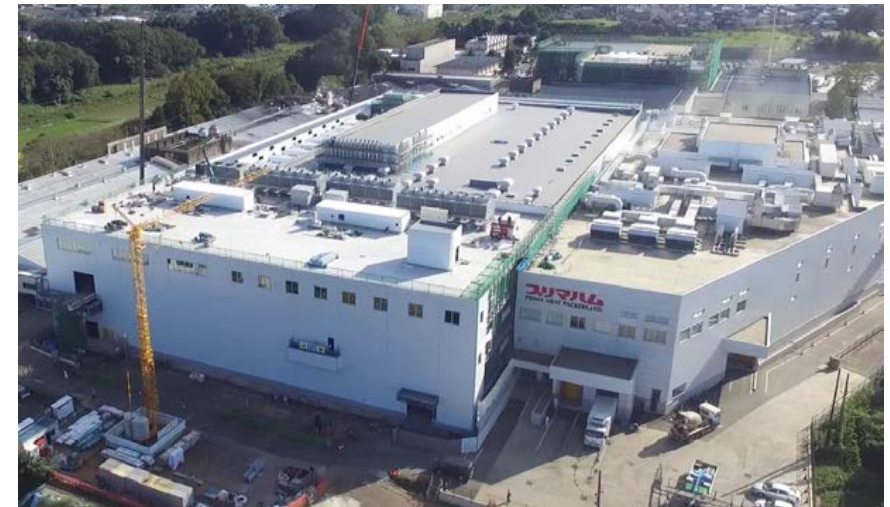
茨城工場〔建設中のハム・ベーコンプラント(左)とウイナープラント(右)〕
