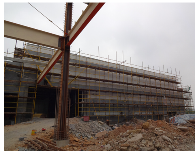
外壁のタイル工事が始まる
