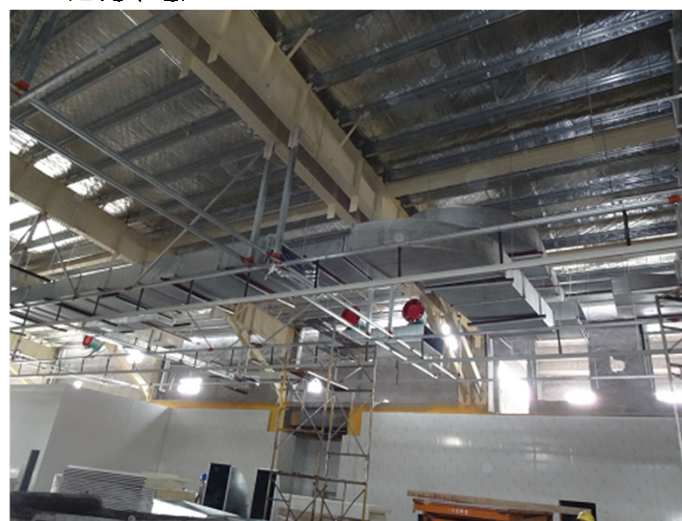
屋根伏せ、ダクト、天井吊、パネルと内部工事が進む。
