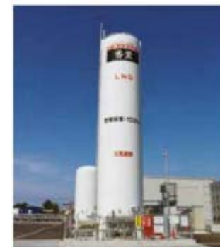
Kagoshima Plant LNG (Liquefied Natural Gas) Tank
