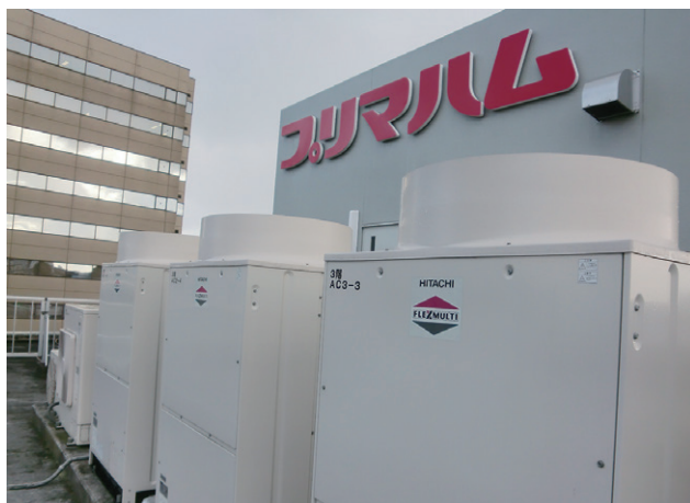
ヒートポンプ式パッケージエアコンに更新 省エネに大きな効果を発揮
