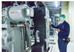
冷凍機システム
