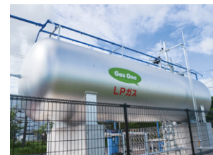
ボイラーに燃焼時の環境負荷が少ないLPG(液化石油ガス)を採用
