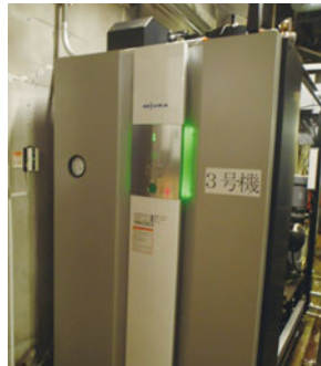
重油ボイラーから LPGボイラーへ更新
