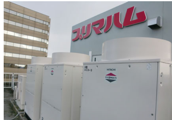
ヒートポンプ式パッケージエアコンに更新 省エネに大きな効果を発揮
