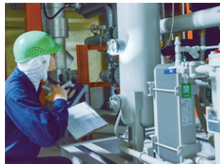
冷凍機の冷媒にはオゾン層に悪影響をもたらすフロンを利用せず、自然冷媒を採用
