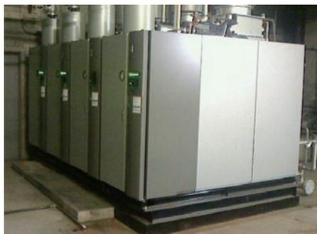
三重工場では4台の中型ボイラーによる台数制御方式を採用
