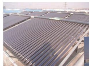
導入した太陽熱温水器
