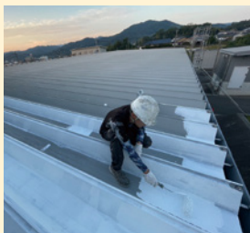
係留場屋根へ遮熱対策を実施
