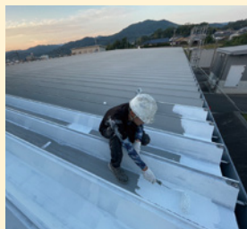
係留場屋根へ遮熱対策を実施
