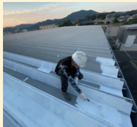
係留場屋根へ遮熱対策を実施
