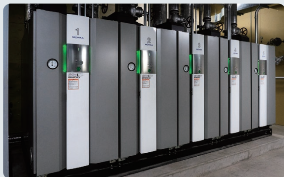
LPガスを燃料とするボイラー機器を採用。工場の稼動状況にあわせて使用台数を調整し、省エネルギーを推進
