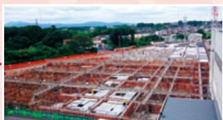
2015年8月下旬 1Fの床部分の工事スタート
