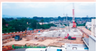
2015年6月上旬 基礎工事完了
