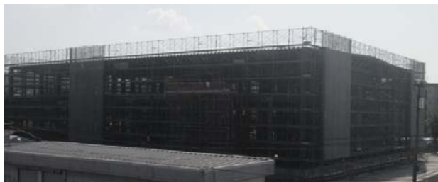
建設中の鹿児島食肉加工場
