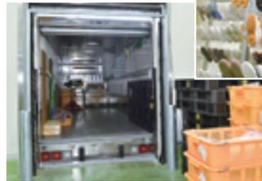
トラックへの積み込み場。商品が外気に触れないよう出口が荷台の枠にあった形に設計されています。
