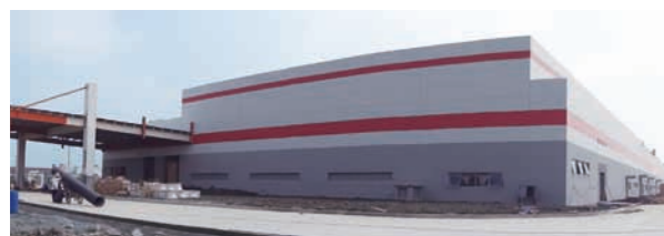
建設中の工場
