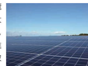
太陽光パネル (龍ヶ崎工場)
